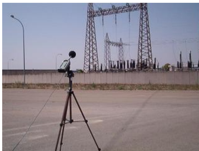
Cabina trasformazione – Alenia
