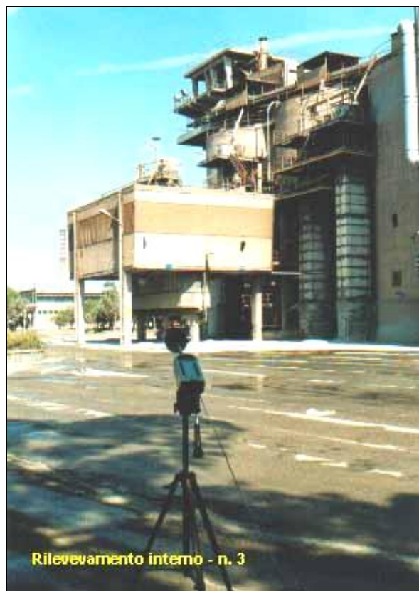
CEMENTIR SpA – Cementerie del Tirreno - Taranto
