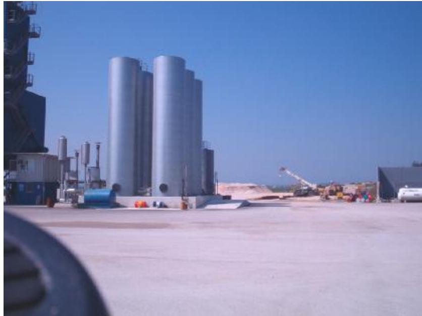
Stabilimento PINTO Srl – Lucera
